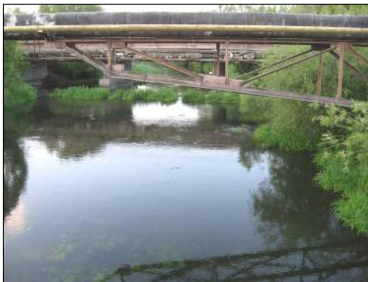
Рисунок 11. Река Россь, мост по дороге от ул. Школьной к филиалу №2 ОАО «Красносельскстройматериалы» (29.05.2009 г.)
